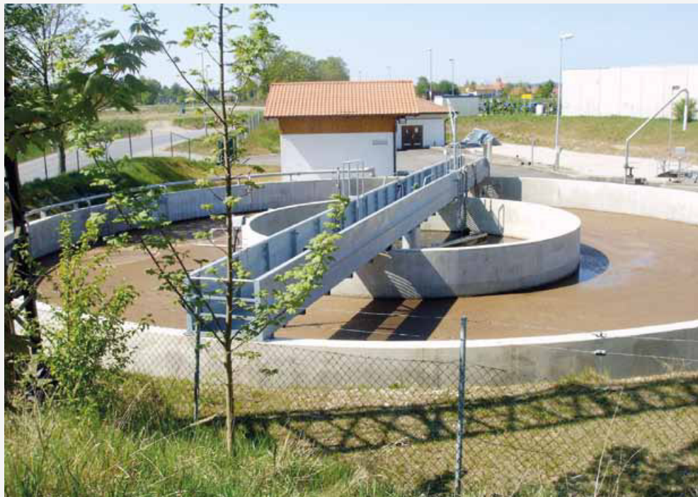
In Kläranlagen soll zukünftig Minischlammfaulung kostengünstig nachgerüstet werden.
