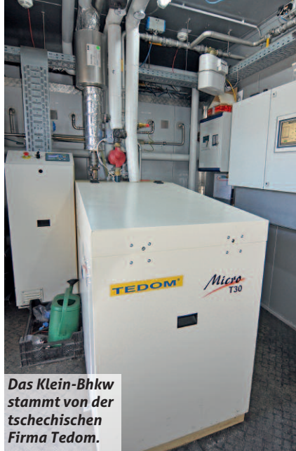
Vor dem Öffnen werden die Boxen von der Seite her belüftet, alle Leitungen sind auf der Rückseite zusammengefaßt. Fotos: Meier
